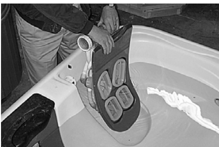
(Figure N) Remove JetPak
